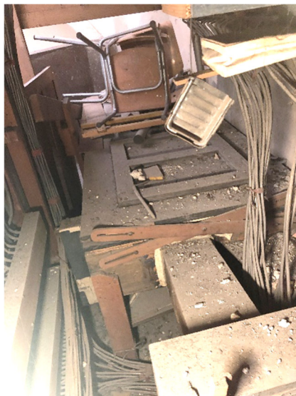
Mantice e canalizzazione.
